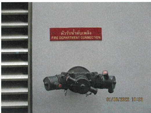
รูปที่ 2-34 ห้รับน้ำดับเพลิงภายนอกอาคาร
