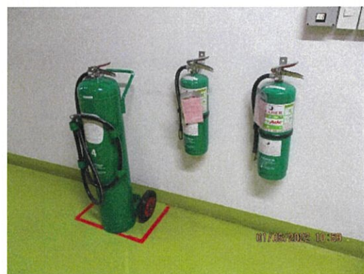
รูปที่ 2-33 ถังดับเพลิงเคมี ชนิด ABC ขนาด 10 ปอนด์
