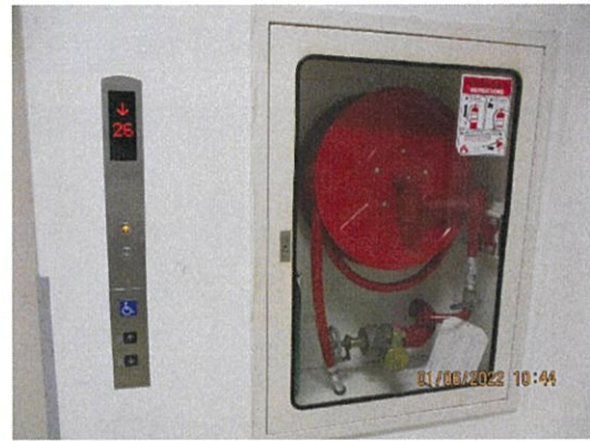
รูปที่ 2-32 ตู้เก็บสายฉีดน้ำดับเพลิงพร้อมอุปกรณ์ (FHC)
