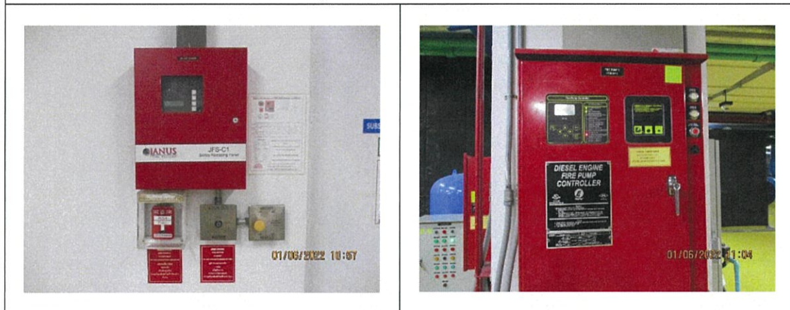
รูปที่ 2-38 ระบบเตือนภัย Fire Alarm Control Panel : FCP
