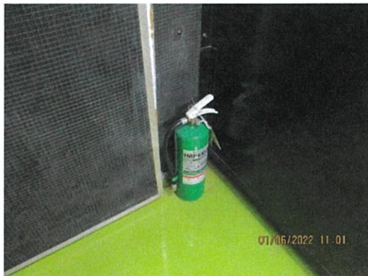
รูปที่ 2-33 (ต่อ) ถังดับเพลิงเคมี ชนิด ABC ขนาด 10 ปอนด์
