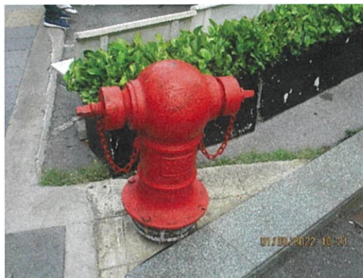
รูปที่ 2-34 ห้รับน้ำดับเพลิงภายนอกอาคาร
