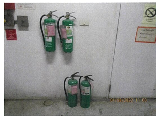
รูปที่ 2-33 ถังดับเพลิงเคมี ชนิด ABC ขนาด 10 ปอนด์
