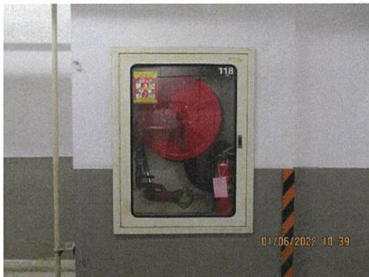
รูปที่ 2-32 ตู้เก็บสายฉีดน้ำดับเพลิงพร้อมอุปกรณ์ (FHC)
