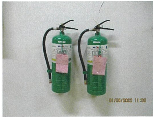
รูปที่ 2-33 (ต่อ) ถังดับเพลิงเคมี ชนิด ABC ขนาด 10 ปอนด์
